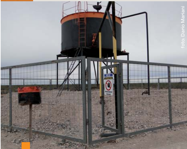
Tanque sobreelevado de petróleo, utilizado en lugares donde todavía no existe un oleoducto, y el petróleo es transportado mediante camiones tanque.
