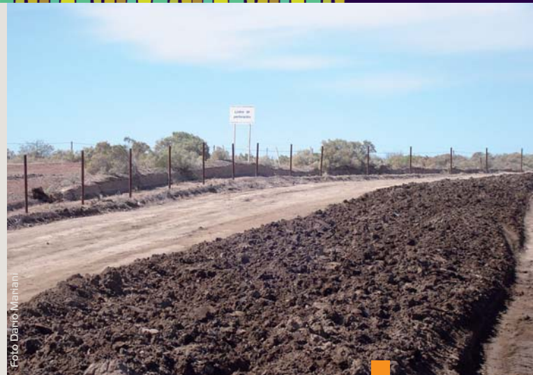
Celda de tratamiento ya homogeneizada y regada con la solución de bacterias.
