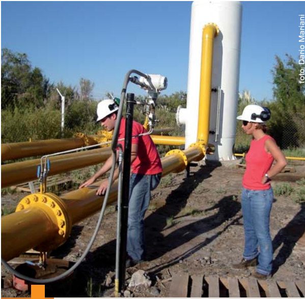
Sobre el fondo de la foto, en color blanco, se puede observar un separador de gas y petróleo.
