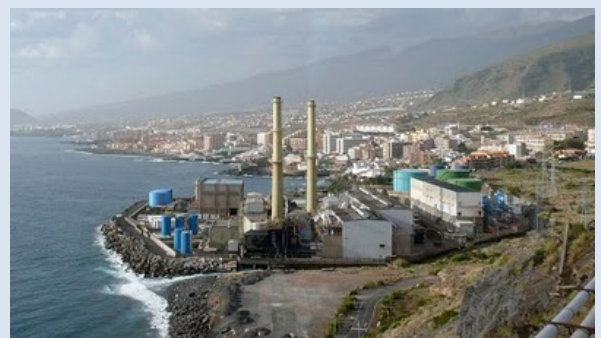
Contaminación por central térmica
